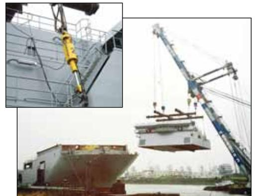
▲ Абсолютно синхронное блансирование: Надстройка военного корабля весом более 600 тонн устанавливается на корпус с использованием гидравлической системы SynHoist.
